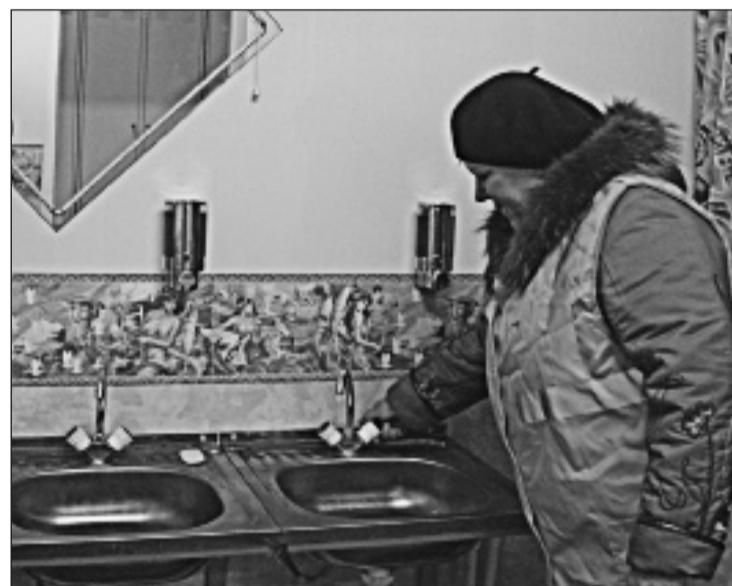
В ПТОВ установлена современная сантехника.
